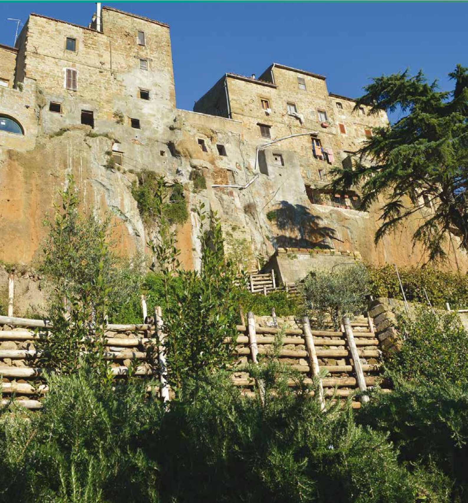
Foto 8.19 Consolidamento rupe tufacea - Intervento 431/02 - Pitigliano (GR) Fonte ISPRA Daniele Spizzichino - Francesco Traversa
