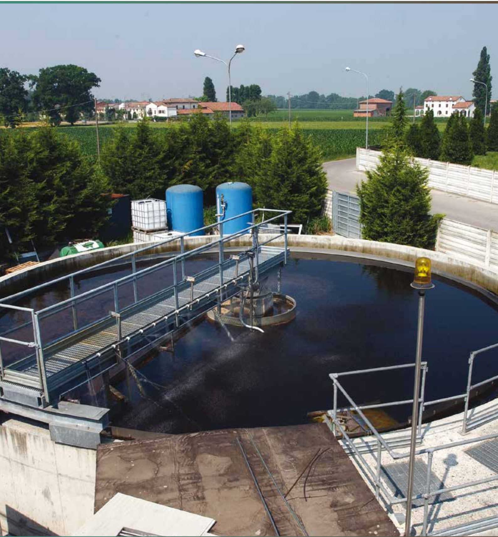
Foto 5.12 Sedimentatore con carroponete Fonte ISPRA Paola Orlandi
