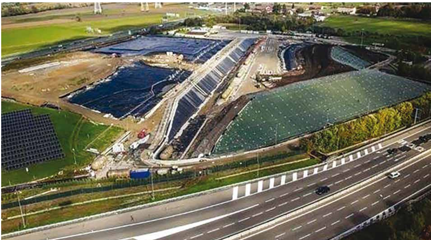
Foto 5.09 Discarica per rifiuti pericolosi Collegno (TO) Fonte Barricalla S.p.A.
