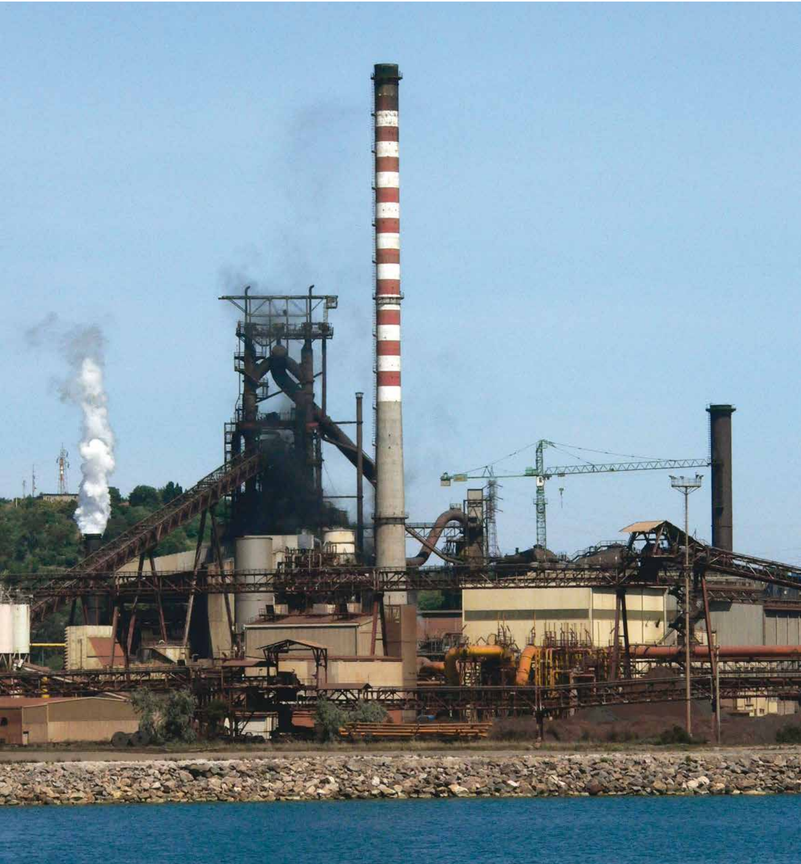
Foto 6.14 Impianti industriali Fonte ISPRA Franco Iozzoli
